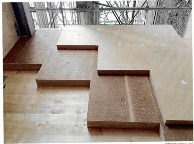
Die Decken spannen als Zweifeldträger über die kurze Länge des Gebäudes. Auf diese Weise ragt keine Platte über die Grenze einer Wohnung hinaus und in eine andere hinein, was dem Schallschutz und auch dem Brandschutz zugute kommt.
