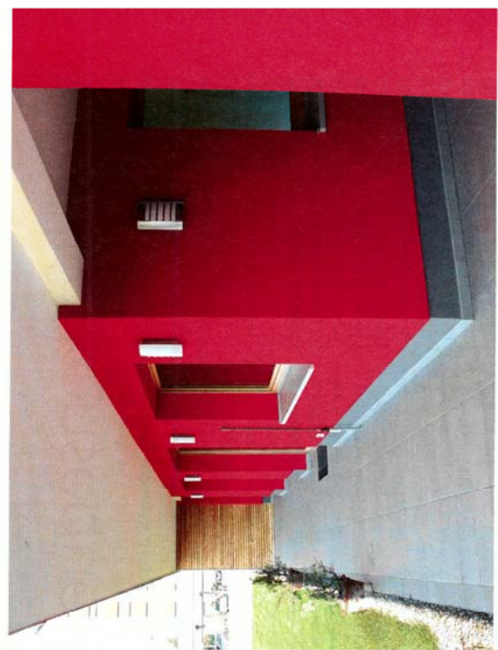
Ein pragmatisches Mittel gegen Bodenfeuchte ist ein Betonsockel, wie er bei den Erdgeschossaußenwänden ausgeführt wurde.
